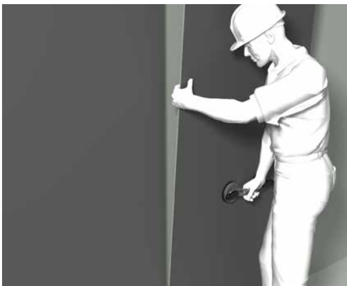
Platte mit Sauger setzen
