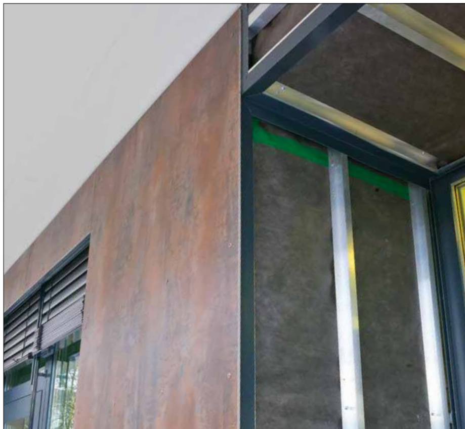
Aluminium Unterkonstruktion
